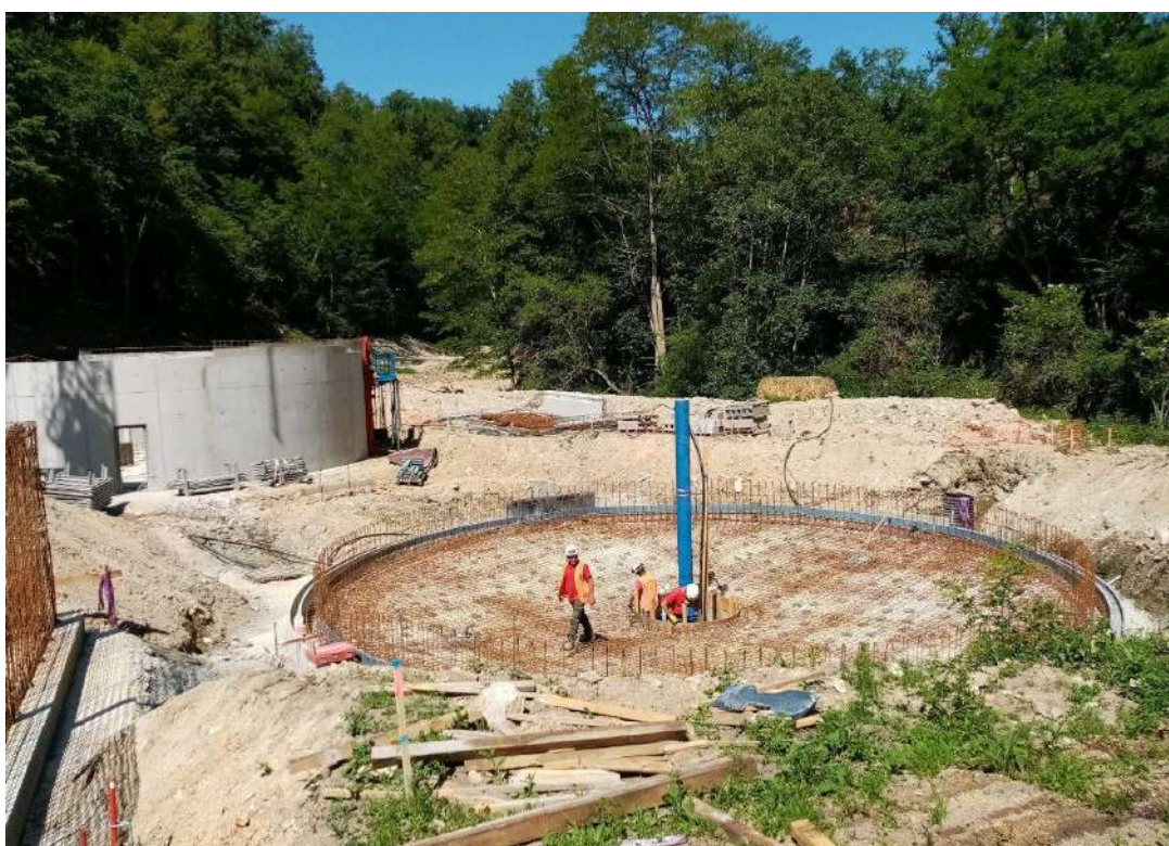
Construction du clarificateur de la nouvelle station d'épuration du bourg d'Evaux-les-Bains
