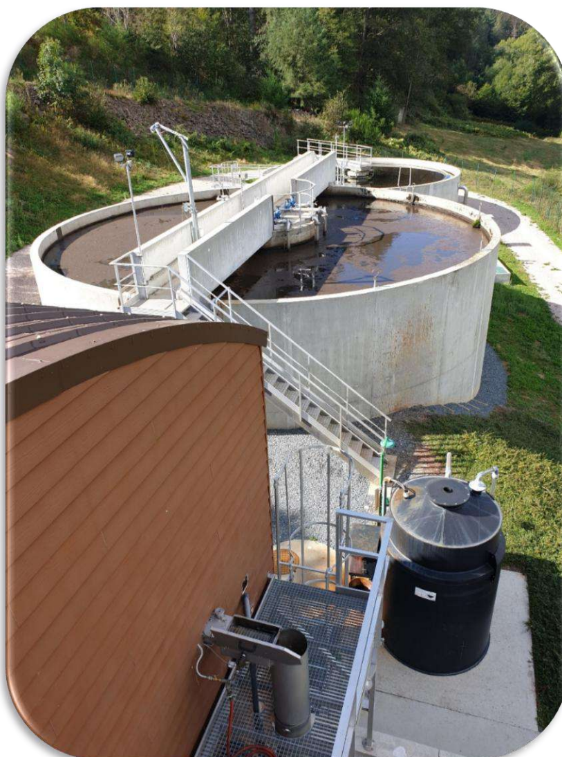
Station d'épuration de l'agglomération de Boussac
