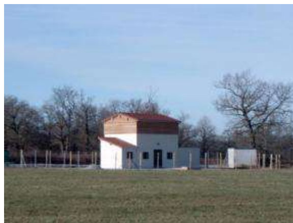
Station de Traitement Varennes Lussat
